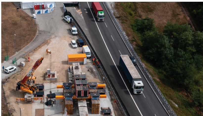
Trave in CAP durante la prova di carico
