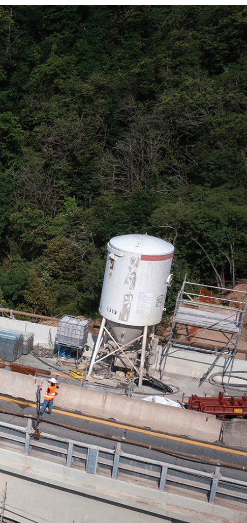
Studenti di ingegneria del Politecnico di Torino durante una visita tecnica sui cantieri del viadotto Teccio (A6) con i carroponte per le attività di montaggio e smontaggio
