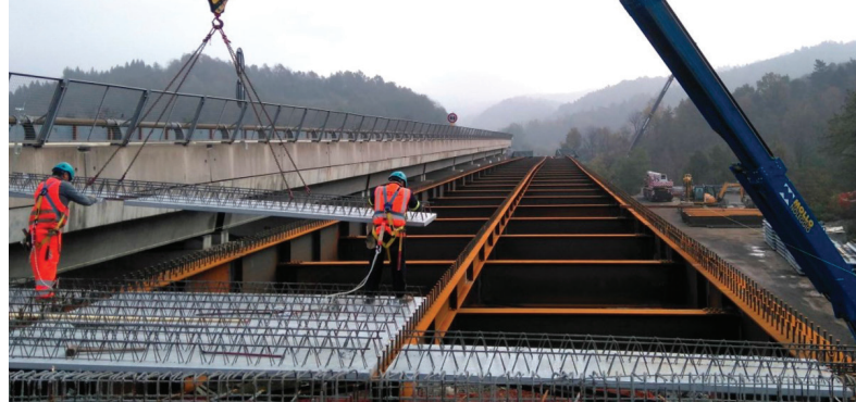
Decostruzione e ricostruzione del viadotto Mollere
