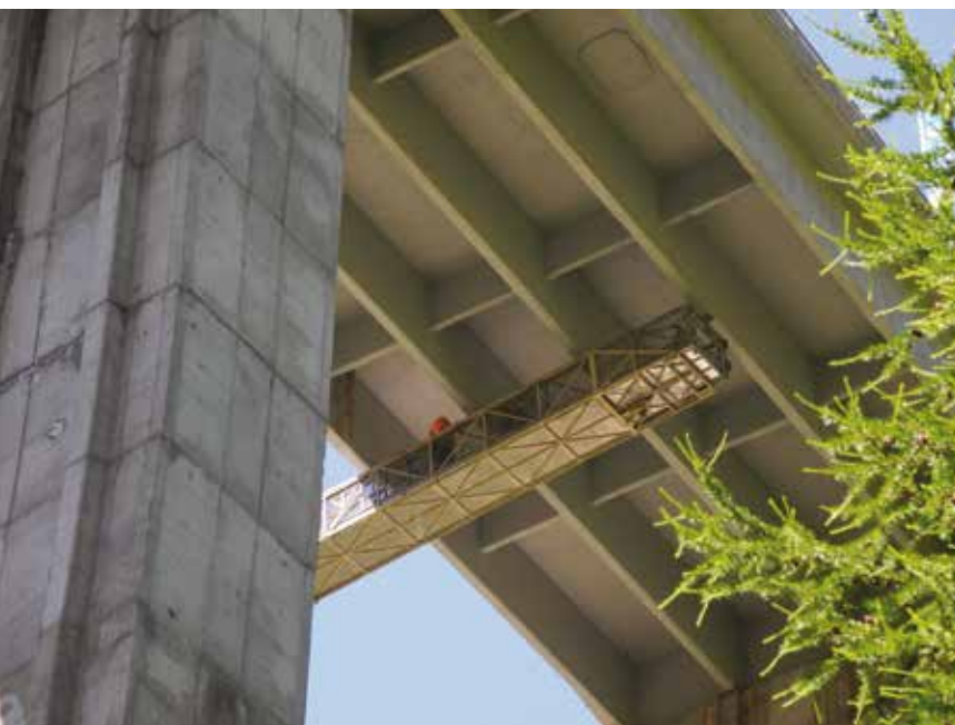
1. Ispezione con By-Bridge
