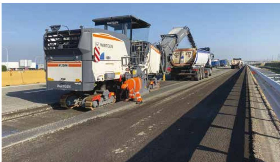
5. La fase di fresatura del manto stradale esistente presso il campo prove dell'Autostrada A4 a Ottobre 2022
