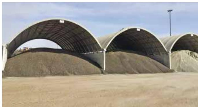
4. Esempio di stoccaggio controllato del RAP al campo prove in A4 a Ottobre 2022
