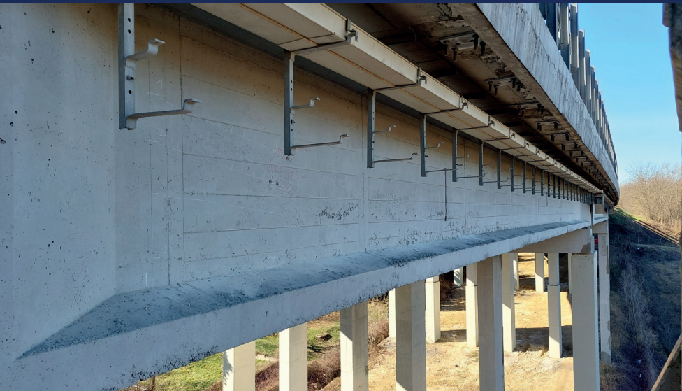
1. Tracciamento cavi post-tesi (in bianco), aree evidenziate dal tomografo (in rosso) e fori per le videoispezioni
