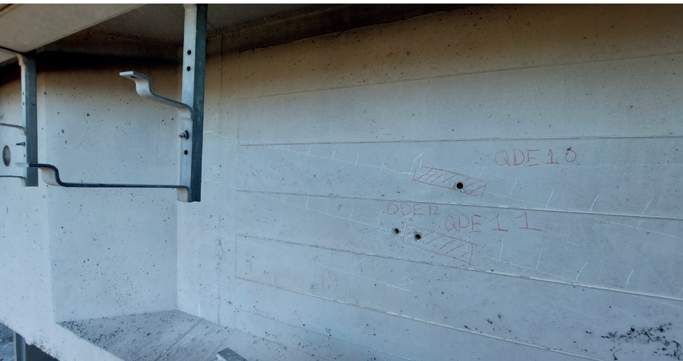
1. Tracciamento cavi post-tesi (in bianco), aree evidenziate dal tomografo (in rosso) e fori per le videoispezioni
