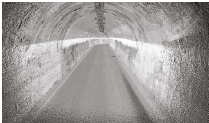
8. Una nuvola di punti 3D della galleria 009G02 sulla S.P. 9 "Val D'Ultimo"
