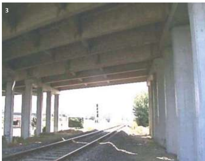
3 - Scavalco sulla linea ferroviaria Asti-Casale
