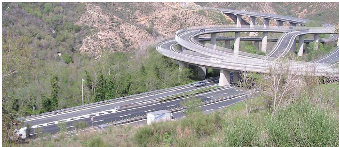
2 – Panoramica lato Ovest
