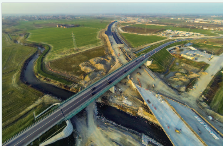
1. Il cantiere della Tangenziale Est Esterna di Milano
