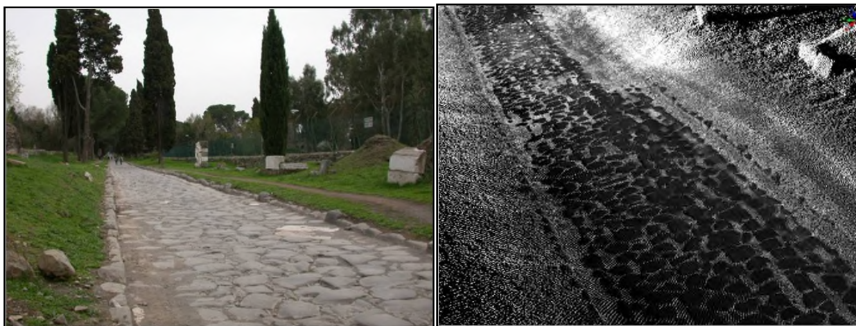
Figura 13 - Esempio di analisi approfondita relativa alla pavimentazione dell'Appia Antica
