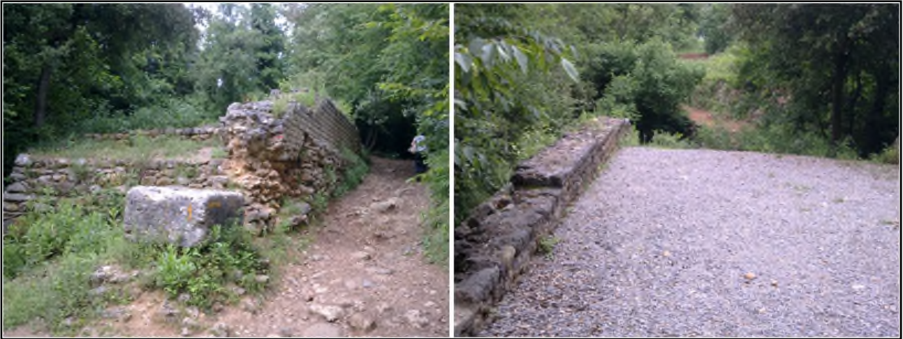
Figura 2 - Del Ponte Sordo rimane solo una rampa di parapetti
