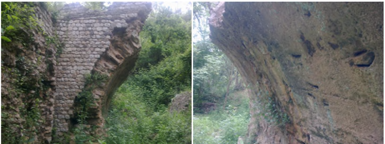
Figura 7 - Ponte di Magnone
