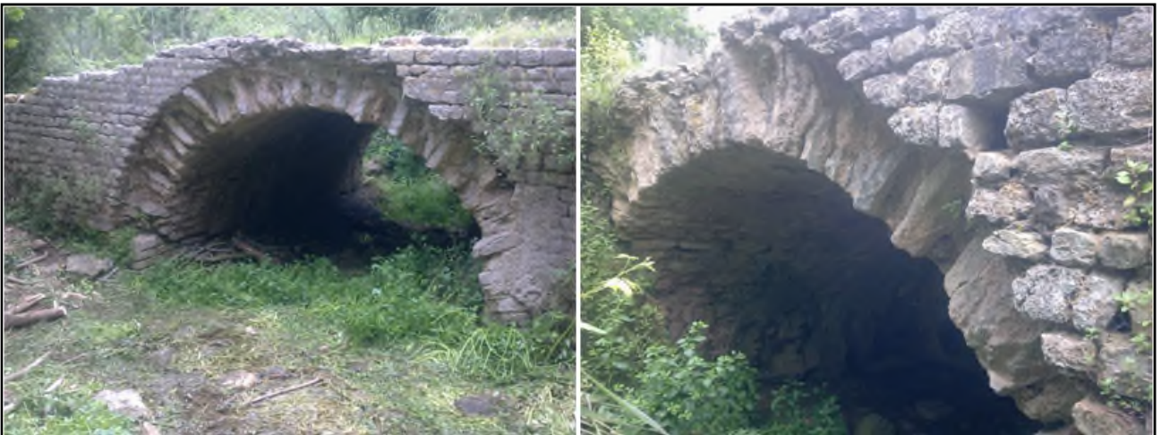
Figura 5 - Ponte dell'Acqua o Ponte di Portio
